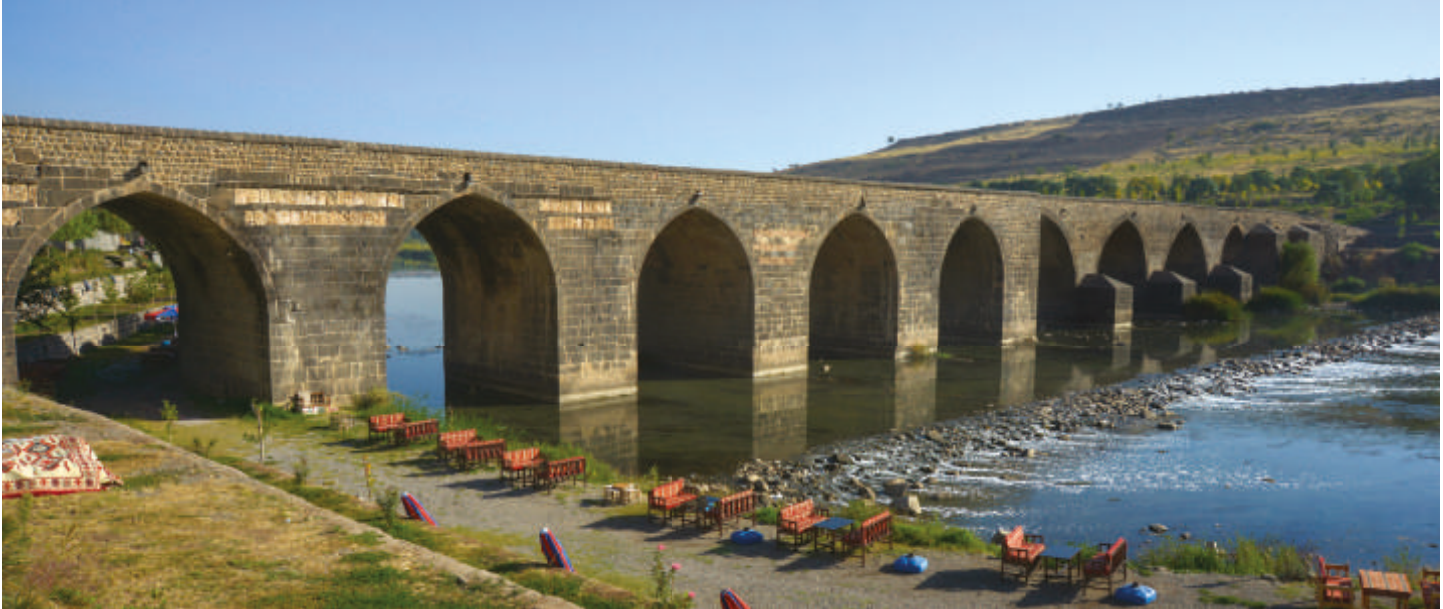
Diyarbakır'da, Dicle üzerine Mervaniler Dönemi'nde yaptırılmış olan On Gözlü Köprü. —
