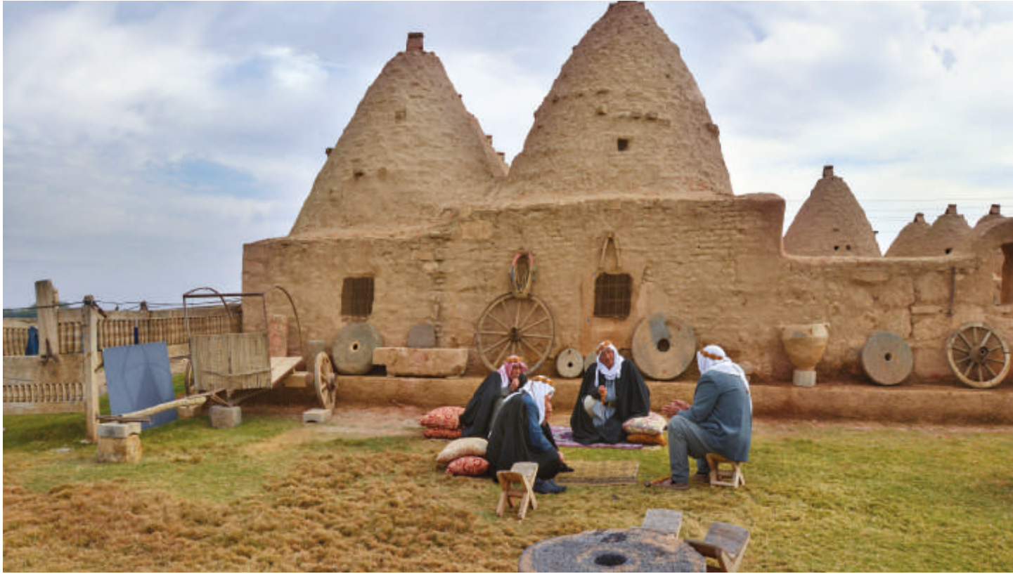
Mezopotamya'da kereste bol bulunmadığı için insanlar merteksiz çatı yapmayı öğrenmiş. Harran'ın kubbe çatılı evleri de bu şekilde inşa edilmiş.
